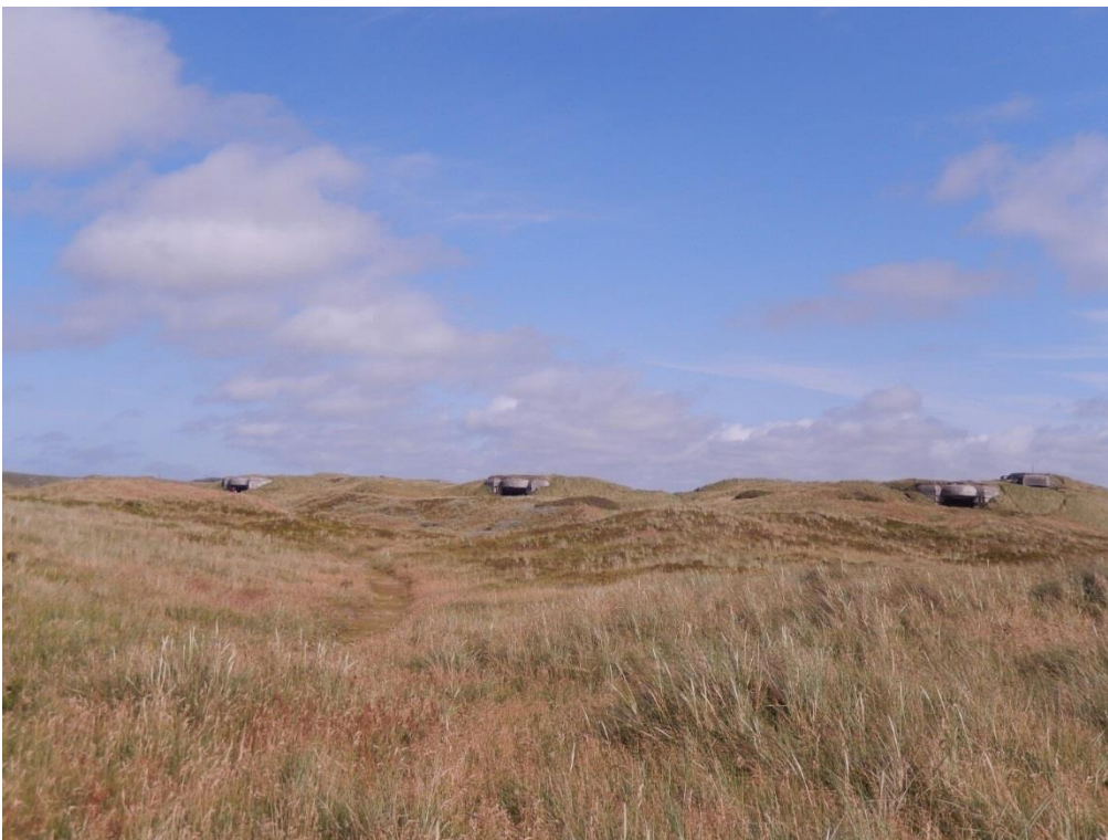
Batteri 1 lige syd for Hanstholm. Bunkerne kan stadig tydeligt ses i terrænet.
